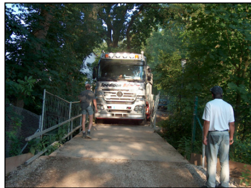
Abb. 3: Antransport der Fertigstation
