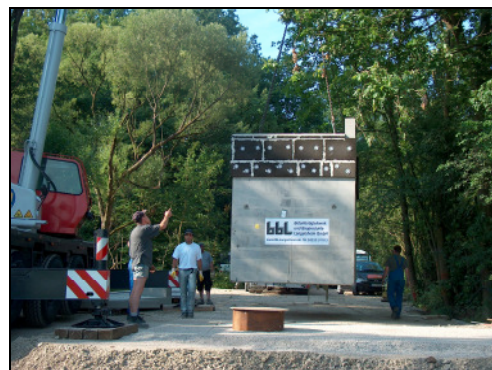
Abb. 4: Millimetergenaues Aufstellen der Fertigstation
