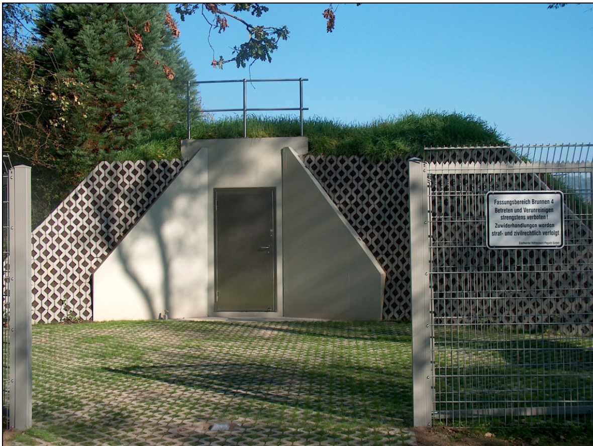
Abb. 1: Ansicht der Brunnenstation
